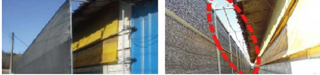
차광막 및 분무노즐 설치
