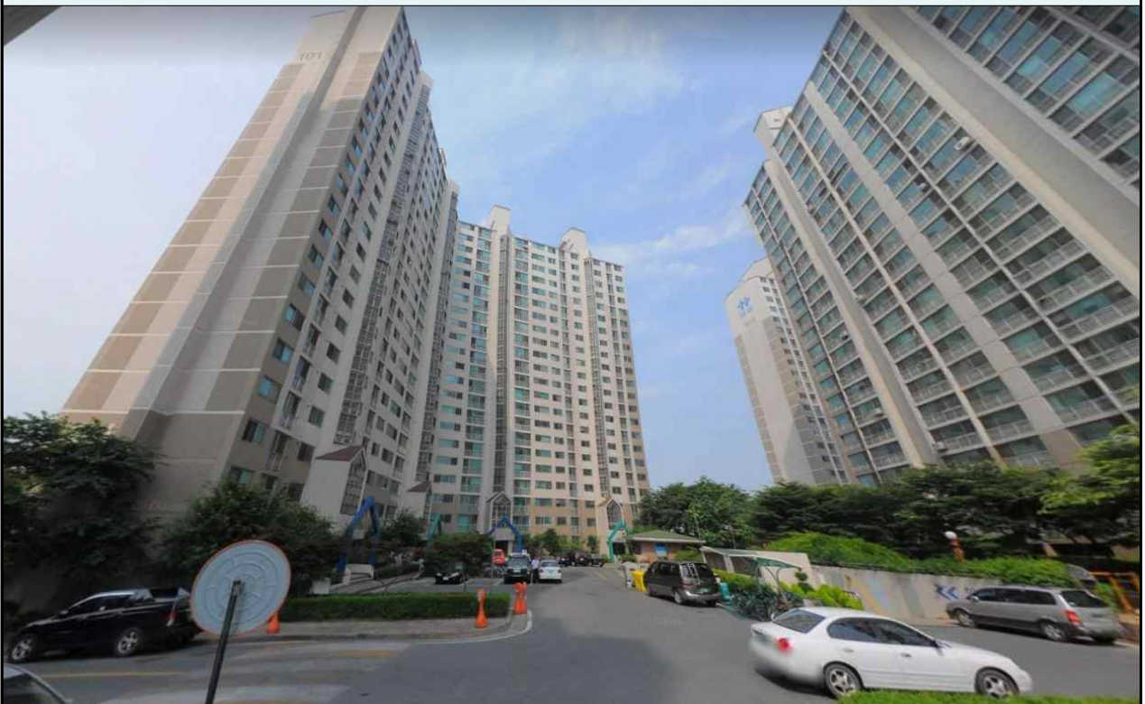
현장사진(논산시 대림길 7(부창동, 대림아파트))
